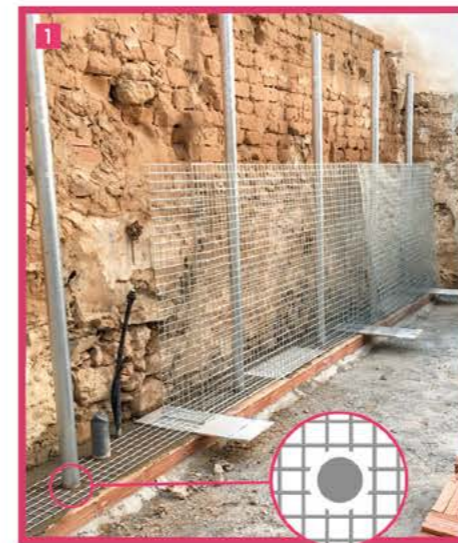
Fijación de postes
